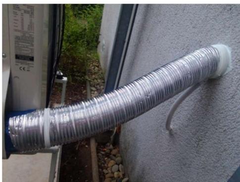
Abbildung 20 Luft/Luft Wärmepumpe mit 3.2 kW max. Heizleistung bei der Montage im Passivhaus Darmstadt Kranichstein; links oben: Außeneinheit; links unten: Hochgedämmte Kältemittelleitungen; rechts: Inneneinheit.
