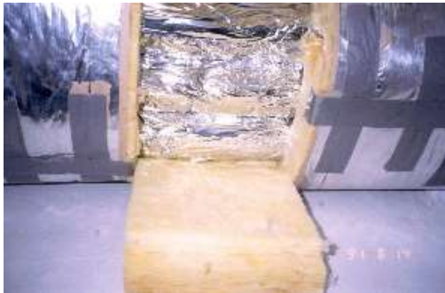
Abbildung 33 Die Wärmedämmung der warmwasserführenden Leitungen im Deckenkanal / Passivhaus Darmstadt Kranichstein mit einer Dämmdicke von (25 + 100) mm (Baustellenfoto von W. Feist 1991)
