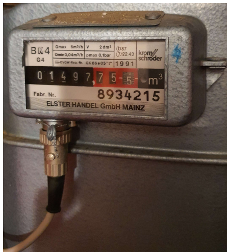
Abbildung 22 Balgen-Gas-Unterzähler mit Impulsausgang für die Kochgasmessung
