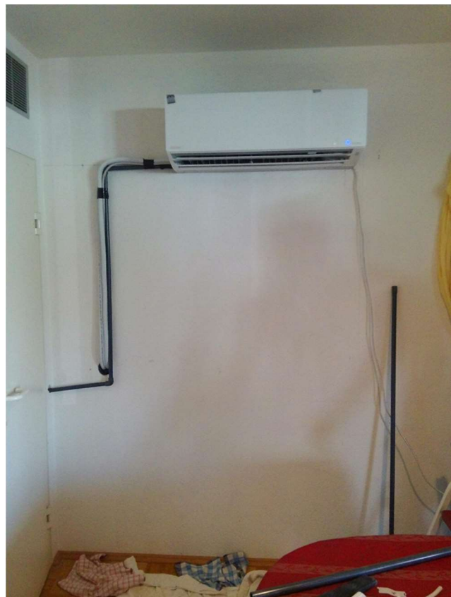
Abbildung 20 Luft/Luft Wärmepumpe mit 3.2 kW max. Heizleistung bei der Montage im Passivhaus Darmstadt Kranichstein; links oben: Außeneinheit; links unten: Hochgedämmte Kältemittelleitungen; rechts: Inneneinheit.
