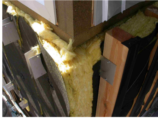
Aufbau hinterlüftete Fassade
